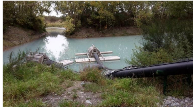
Vandpumpe ved floden
