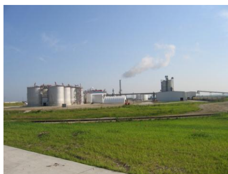
Ny fabrik for bioethanol – lavet ud fra tidligere foderstoffaciliteter
