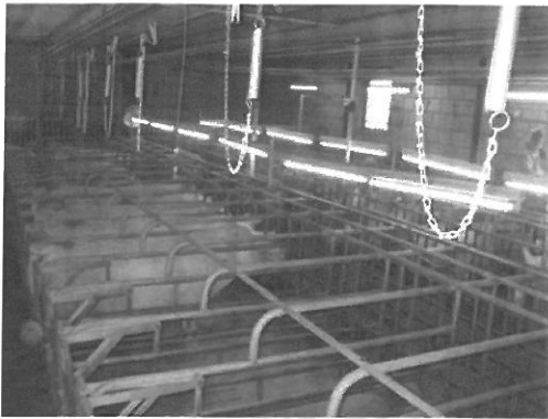
Foto 7. Løbestaldsbokse i den ene besætning. Billedet viser lysstofrørens placering over søerne i løbeafdelingen. Kæde og fjeder, som ses på billedet, er til at holde sædportionen således at man ikke behøver at være ved soen mens hun insemineres.
