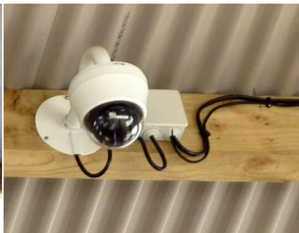
Figur 35 Overvågningskamera i kælvningsstalden
