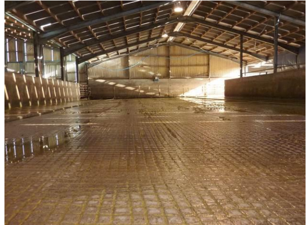
Figur 60 Indendørs opsamlingsplads med profileret gulv.
