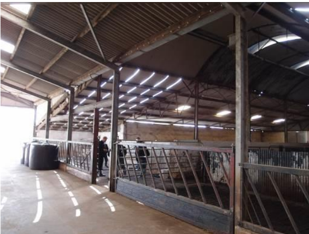
Figur 56 Ventilationsprækker i taget, striber af sollys falder igennem – en simpel konstruktion
