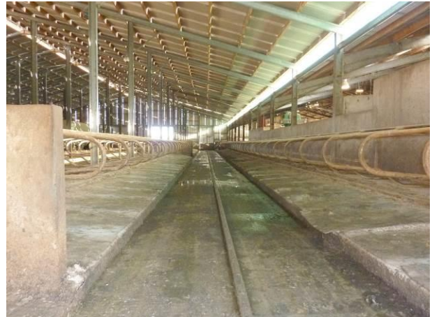
Figur 62 Fast gulv med fastmonteret skraber.
