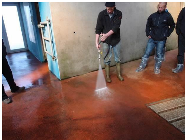
Figur 48 Figur 10 Carborundum-behandlet gulv rengøres 2 gange dagligt
