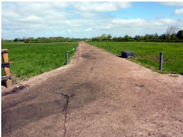
Figur 51 Denne "hoved"-drivvej er belagt med beton.
