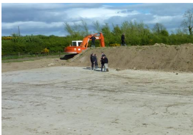
Figur 36 Ensilageplads med jordvold omkring, netop færdig anlagt.
