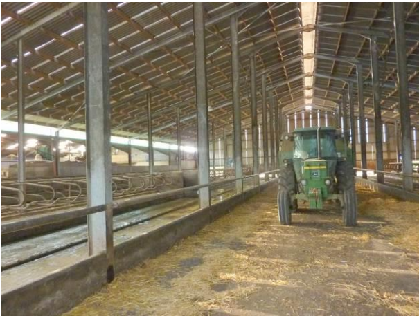
Figur 72 Bygninger med stålrammer og stolpekonstruktion.
