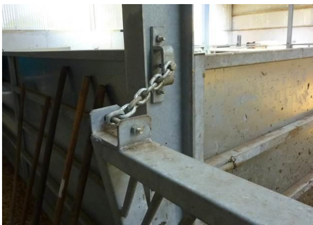
Figur 17 Vinklet forværk, kan vippe ind vha. kæder på de bærende stolper i stalden.
